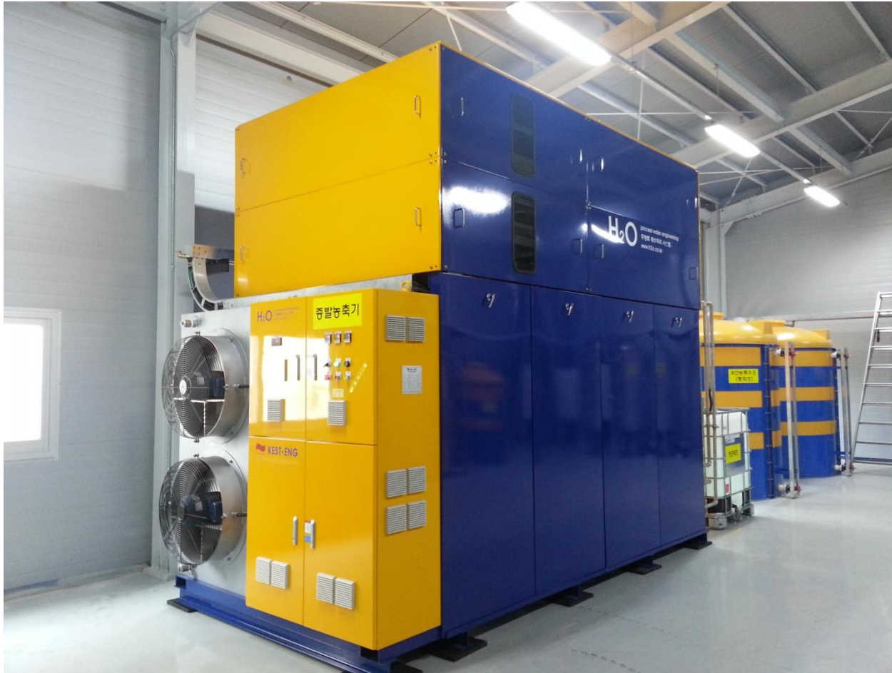
대원강업 도장공정 무방류 폐수처리 시스템 : 일일 50톤
