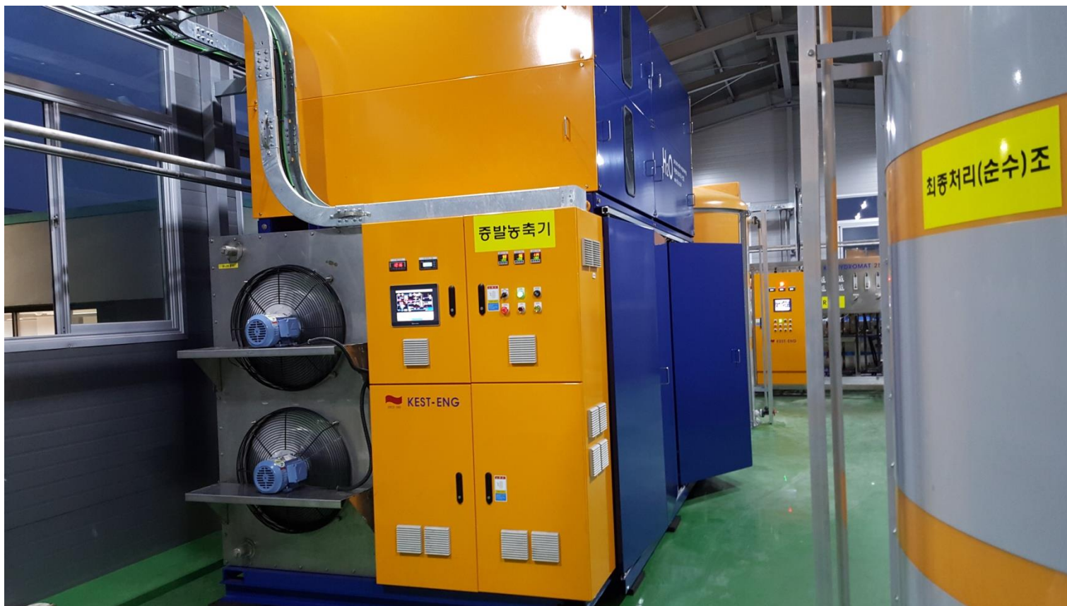
대원강업 창원 전착도장공정 무방류 폐수처리 시스템 : 일일 50톤
