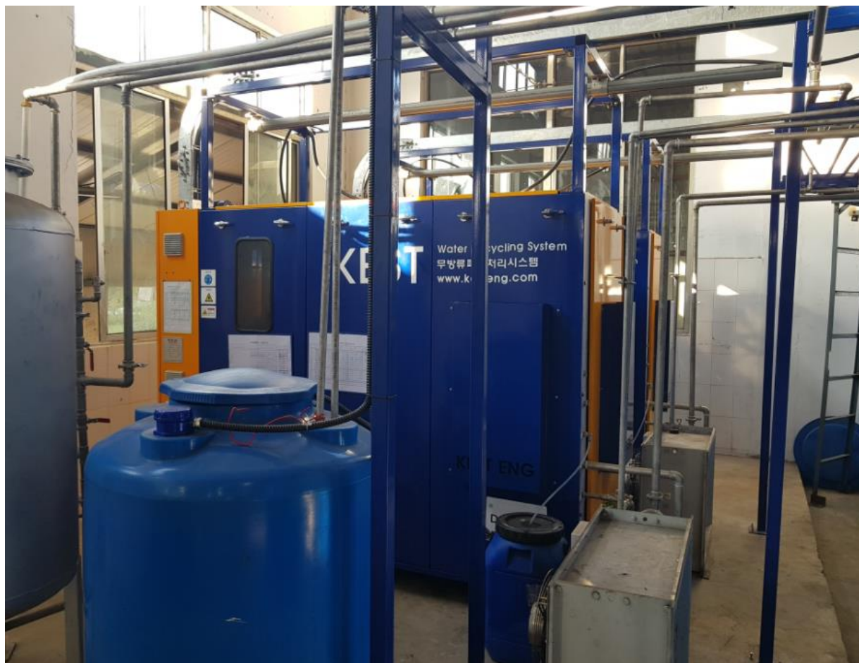
YG1 공구 (칭다오) 열처리 공정 폐수 무방류 처리 시스템 : 일일 5톤
