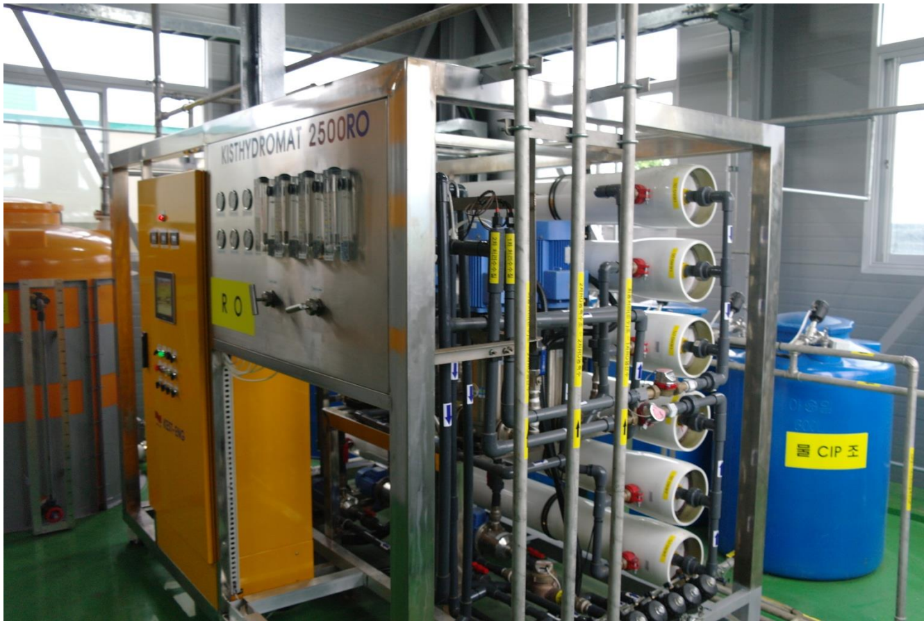
대원강업 창원 전착도장공정 무방류 폐수처리 시스템 : 일일 50톤
