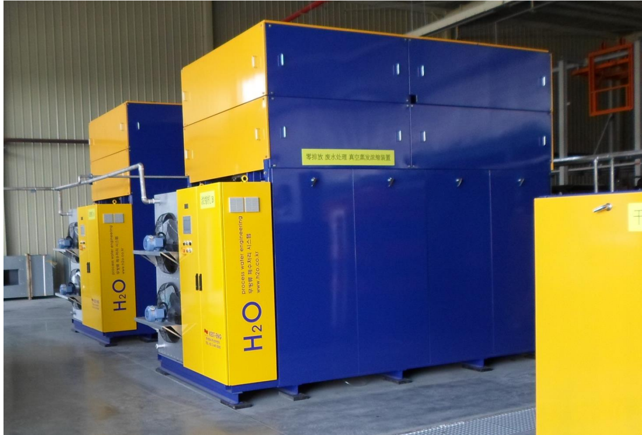
동희산업 중국 염성(옌청) 공장 도장공정 무방류 폐수처리 시스템 : 일일 100톤
